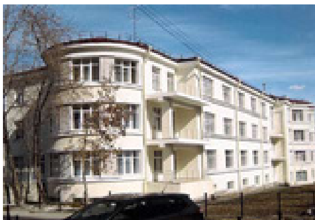
Здание Института физиотерапии на улице Московской
